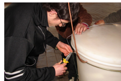
Fig. 2: Armado de tanque de acumulación.
